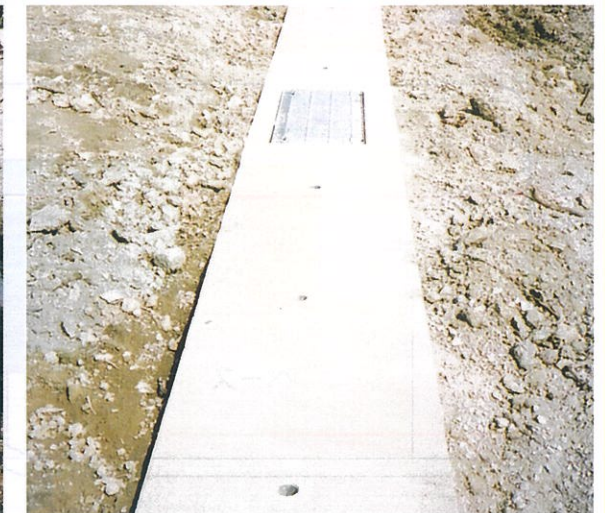
水抜き穴施工風景
